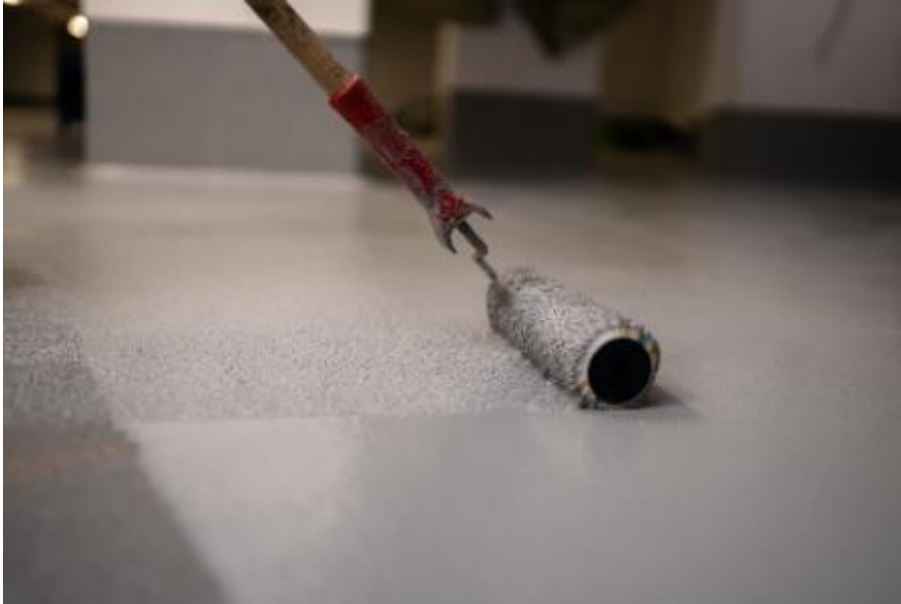
Abrollen der Deckschicht PCI Apoten OS TC (Link zum hochauflösenden Photo )
