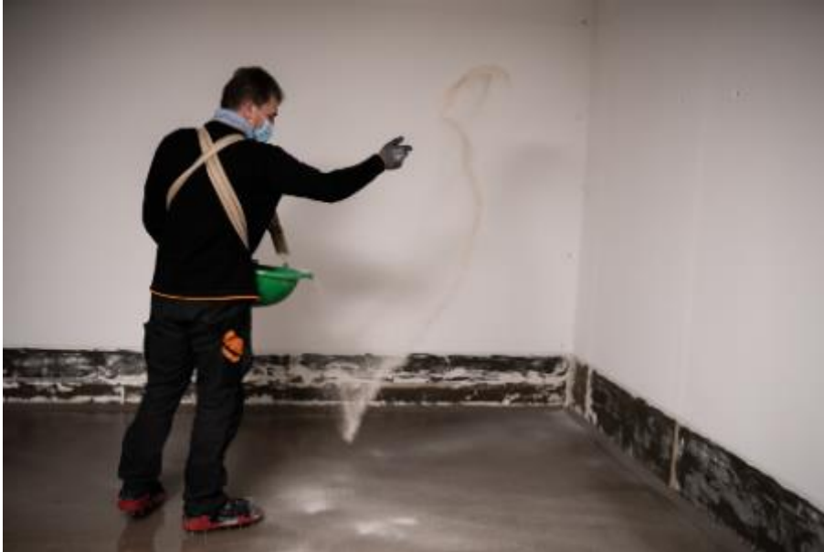
Die frische Kreuzspachtelung PCI Apoten OS P sandeten die Verarbeiter nach dem Auftrag im Überschuss mit Quarzsand 0,3 - 0,8 ab. (Link zum hochauflösenden Photo )
