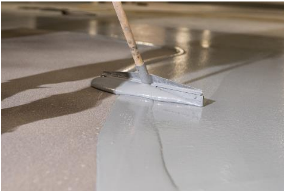
Fluten der abgesandeten Kratzspachtelung mit PCI Apoten OS TC (Link zum hochauflösenden Photo )
