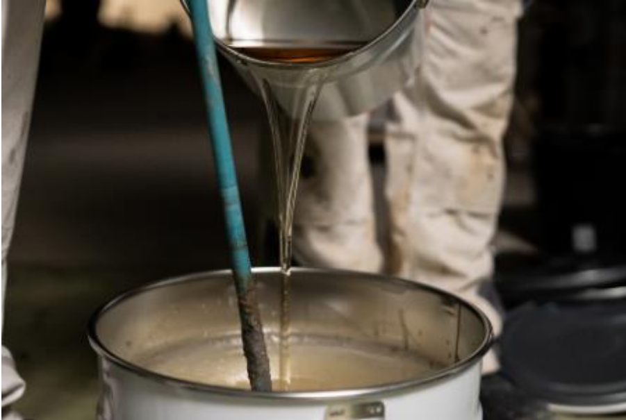
PCI Apoten OS P besteht aus der Basiskomponente A und der Härterkomponente B, die hinzugefügt wird. (Link zum hochauflösenden Photo )
