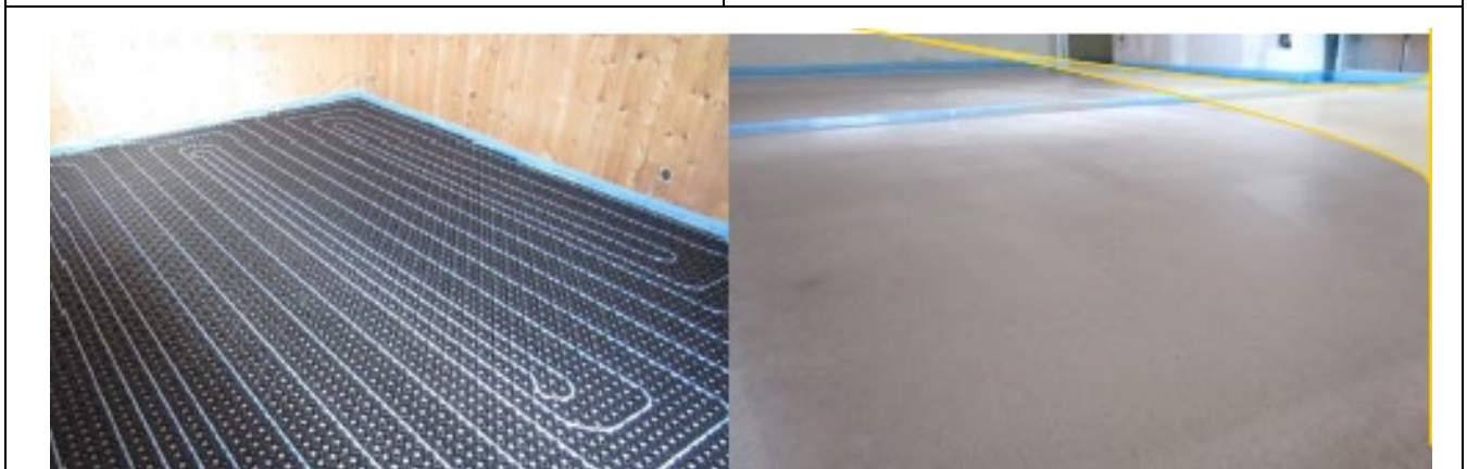
Niedertemperaturheizsystem verlegt auf dem schwimmenden Estrich. Noch ohne Ausgleichsmasse.
