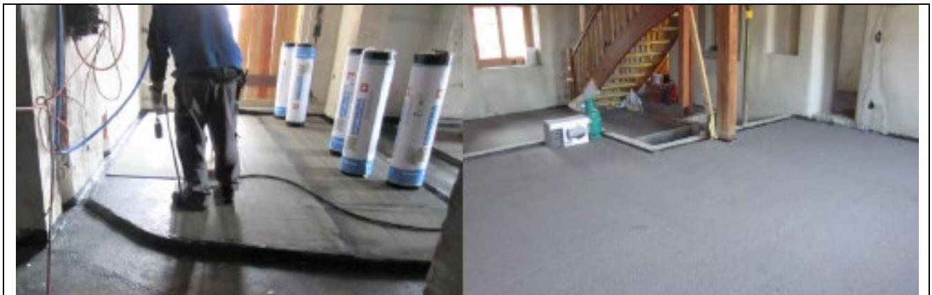
Schwimmender Estrich auf der Bitumenbahn nach spezieller PCI-Rezeptur.
